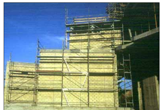
Muros de Bloque de Hormigón Hueco con Costillas® Allwall® dobles, para soportar la acción del viento de 250Km/h, con chapado de piedra.
