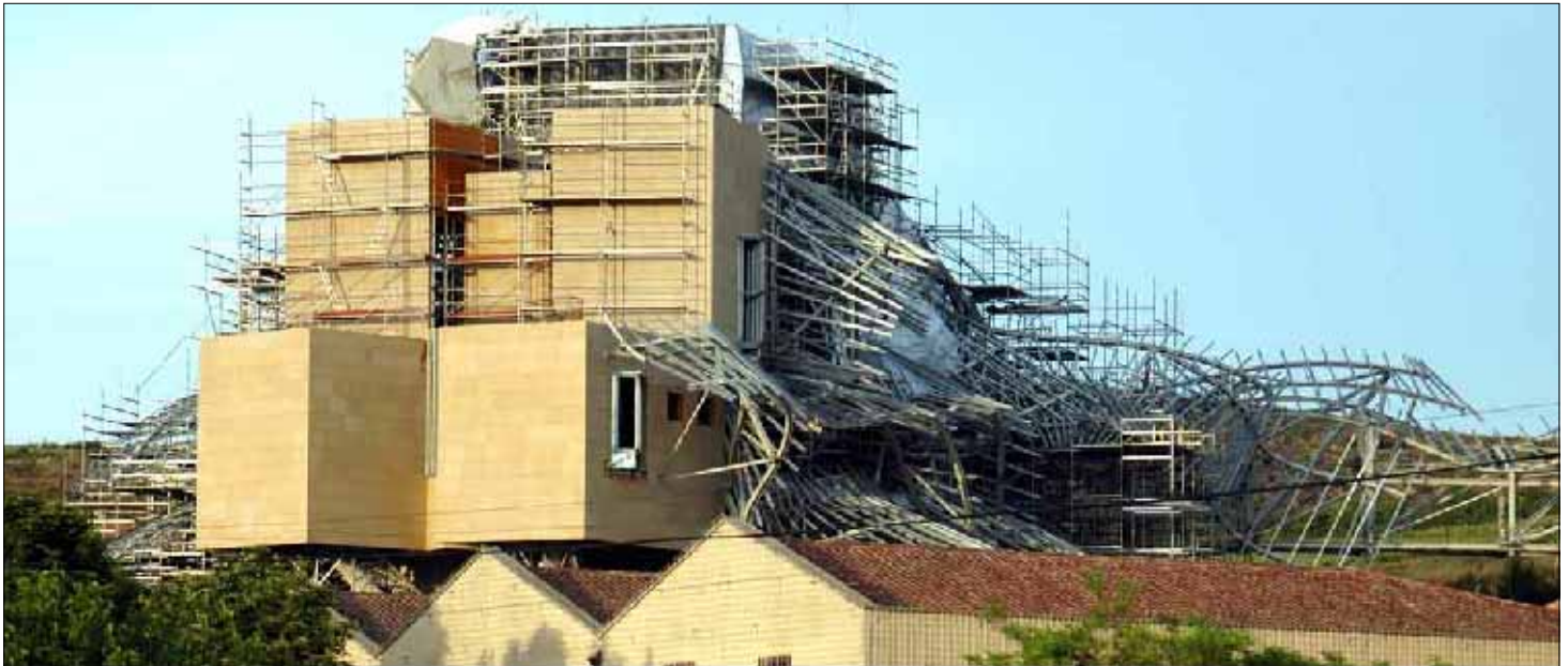
Muros de Bloque de Hormigón Hueco con Costillas® Allwall® dobles, para soportar la acción del viento de 250Km/h, con chapado de piedra.
