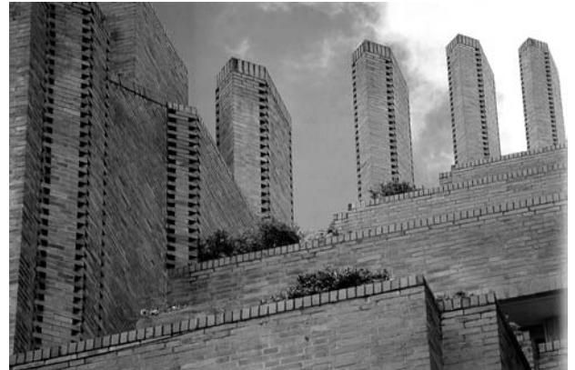
Figura 7.- Chimeneas endentadas en las viviendas de Alto de los Pinos (1976).
