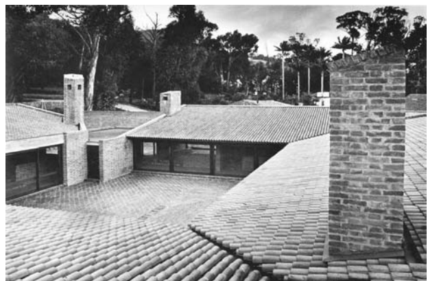
Figura 2.- Casa Alba (Bogotá), paredes y suelos de ladrillo, y cubiertas de teja.
