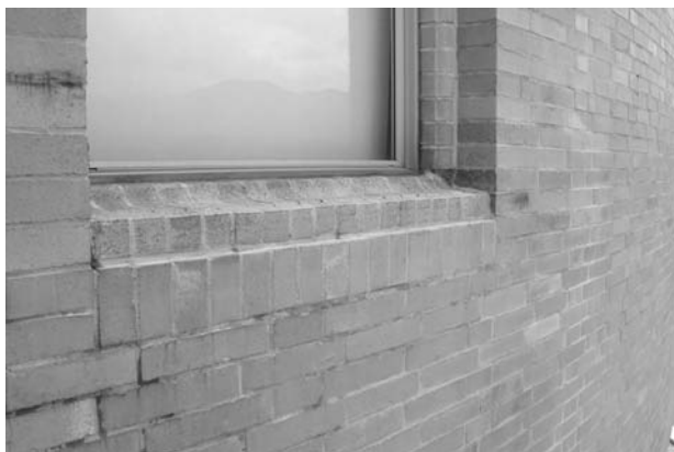
Figura 18.- a) Pieza dintel en su ubicación habitual; b) Pieza dintel dispuesta a modo de vierteaguas.
