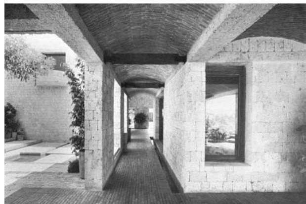
Figura 11.- Vista de los espacios de la Casa de Huéspedes construida en piedra y con bóvedas atirantadas.
