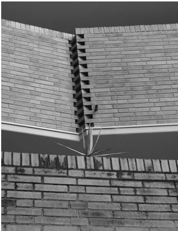
Figura 5.- a) Conjunto de la fachada cóncava de las Torres del Parque; b) Encadenado visto de los paños de ladrillo articulados entre sí.
