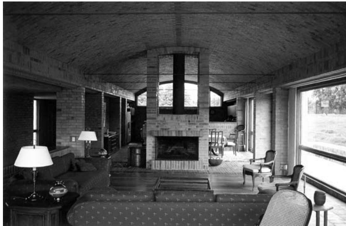
Figura 8.- Bóvedas de ladrillo atirantadas en el interior de la Casa Tenjo en La Sabana (1989).
