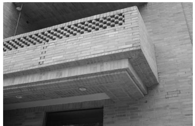
Figura 19.- a) Pieza dintel coronando un peto de barandilla; b) Pieza dintel revistiendo la parte inferior de una terraza.
