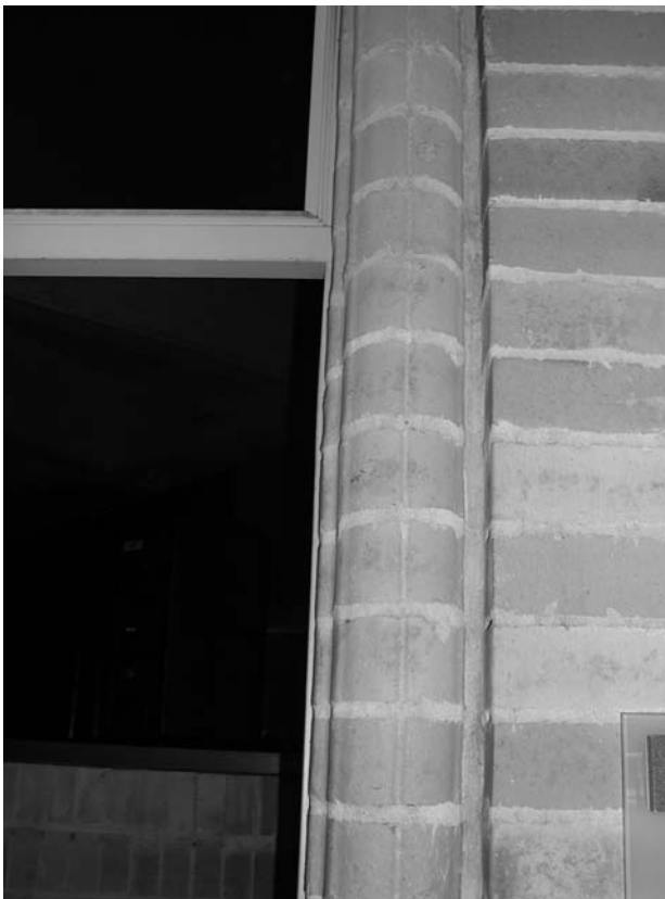
Figura 17.- a) Pieza jamba en su ubicación habitual; b) Pieza jamba conformando una celosía calada.
