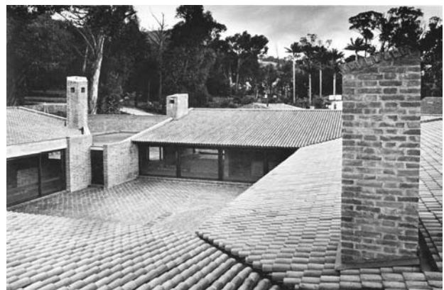
Figura 2.- Casa Alba (Bogotá), paredes y suelos de ladrillo, y cubiertas de teja.
