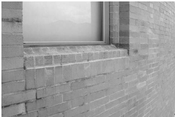
Figura 18.- a) Pieza dintel en su ubicación habitual; b) Pieza dintel dispuesta a modo de vierteaguas.
