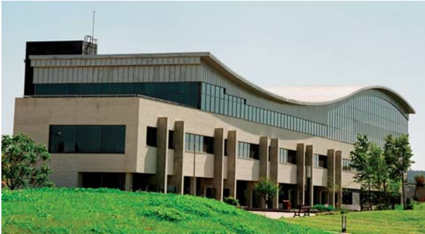
Figura 4a- Empleo de la mampostería de hormigón en la fachada de edificación pública.
