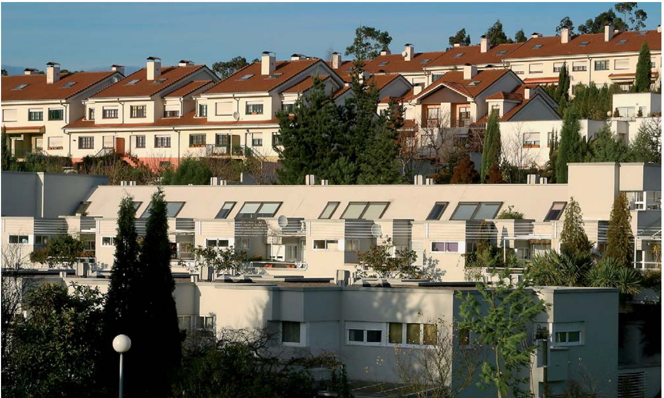
Figura 5b.- Viviendas con mampostería estructural con bloque de hormigón enfoscado.
