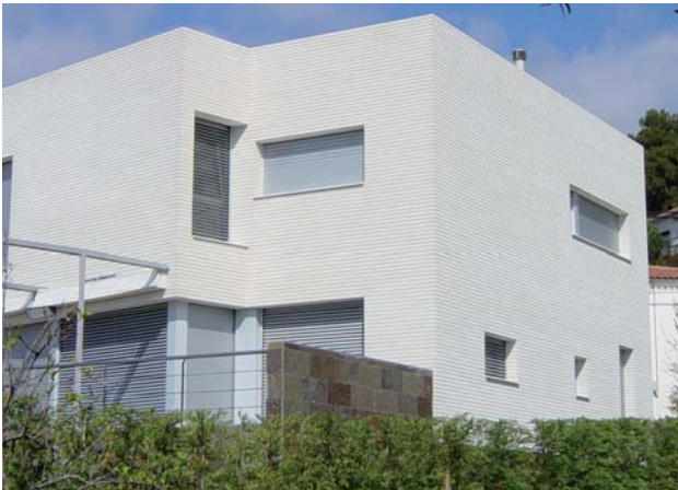
Figura 4b.- Empleo de la mampostería de hormigón en un cerramiento residencial con formato de ladrillo alargado de color blanco.
