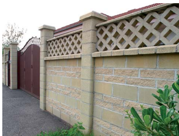
Figura 3b.- Empleo de mampostería de hormigón en muros de cerramiento con distintas geometrías, colores y acabados.
