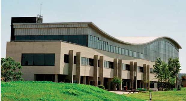
Figura 4a- Empleo de la mampostería de hormigón en la fachada de edificación pública.
